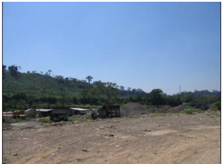
Fotografía 4.2 Trituradora y almacenamiento de materiales
