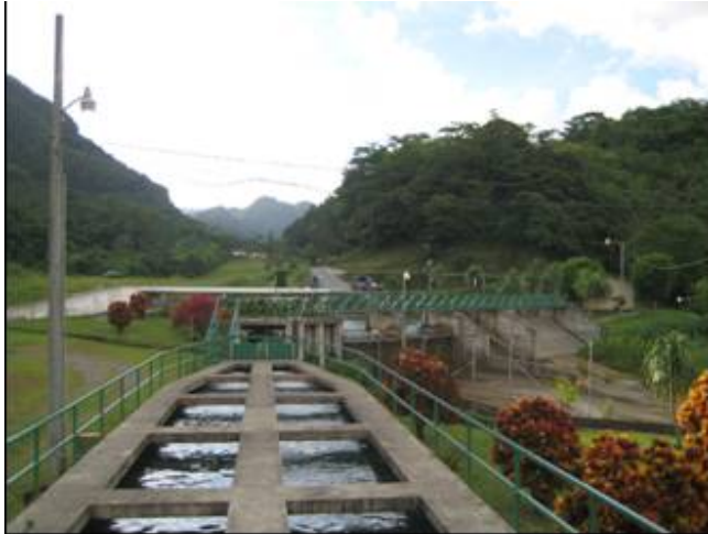
Fotografía 5.3 Vista del entorno de la presa derivadora y sedimentador
