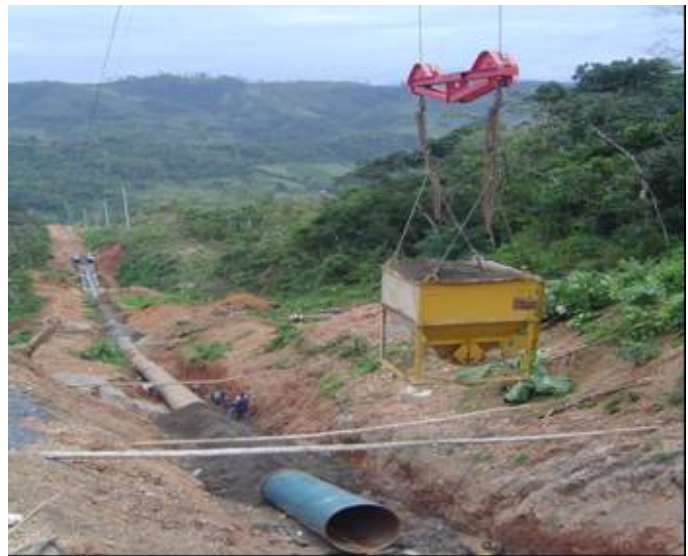
Fotografía 5.2 Vista de la utilidad del teleférico para transportar el concreto. Cortesía R. Tormo
