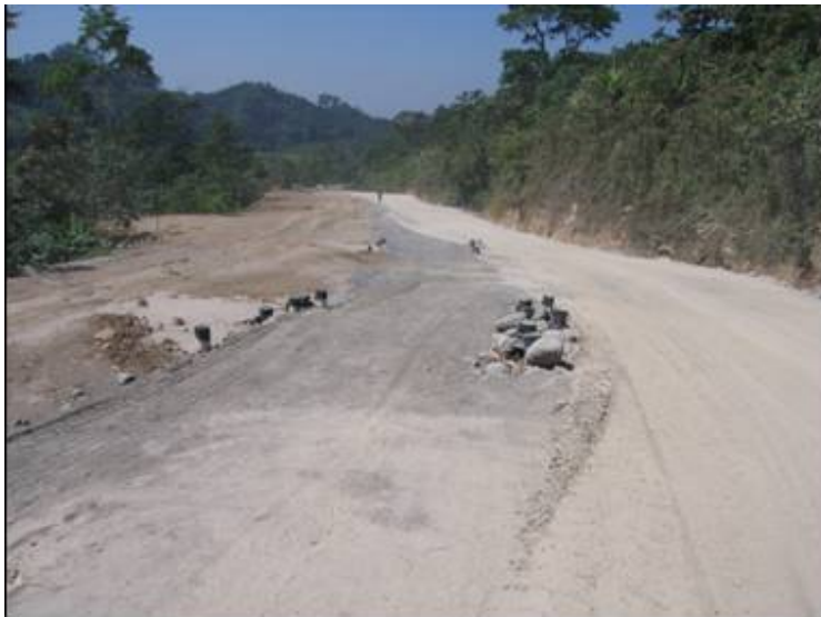
Fotografía 4.1 Camino para colocar la tubería a presión hacia la casa de máquinas
